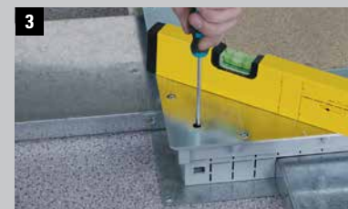
3 Nivelar con los tornillos
