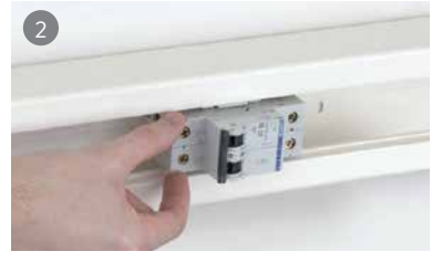
2 Clipar el conjunto en el envoltorio o en la canal portamecanismos.
