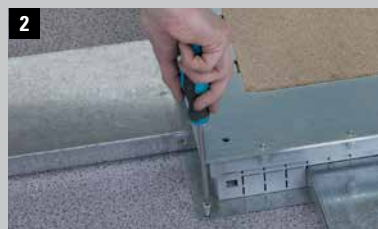
2 Introducir las canales y atornillar al suelo
